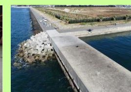
港湾施設点検
