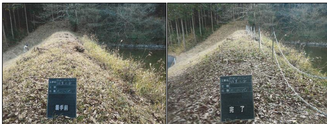
参考_ため池フェンス設置前後
