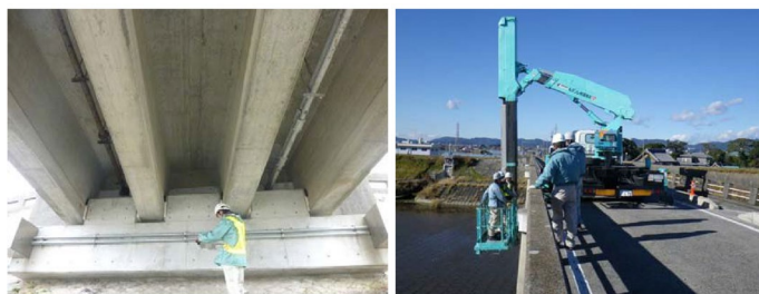
写真：専門業者による点検状況
