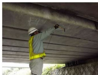
近接目視点検状況：ゲンサウ橋 （萩町）
