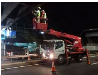
近接目視点検状況：樫王橋 （小坂井町）
