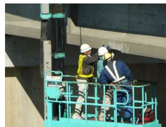
近接目視点検状況：行明橋 （行明町）
