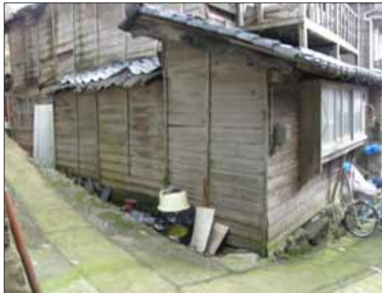
外壁が裸木造の例
