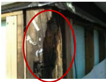
イ：局部的に柱で破損がみられる例
