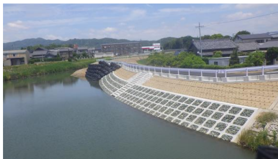
河川改修工事
