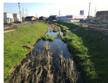
多自然川づくり（西古瀬川）
