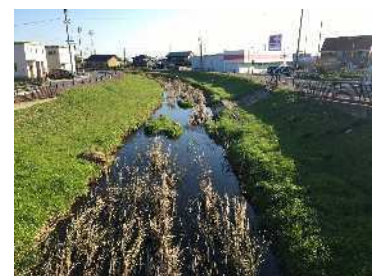
多自然川づくり（西古瀬川）
