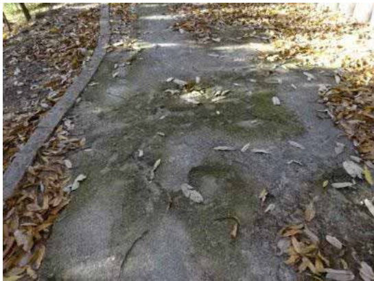
ひび割れしている園路
