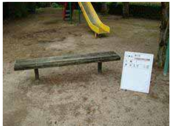
座板の劣化がみられるベンチ
