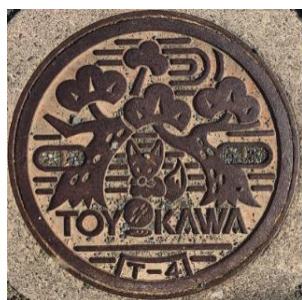
コンクリート製接続ます (直径 50cm 鉄ふた)
