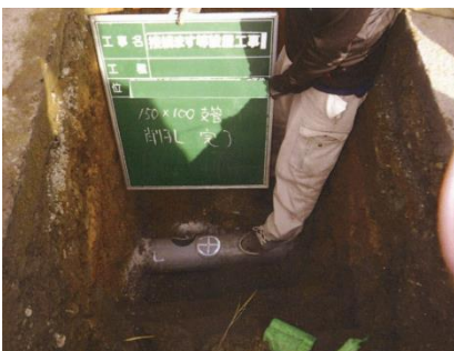
管の上に乗っている写真
