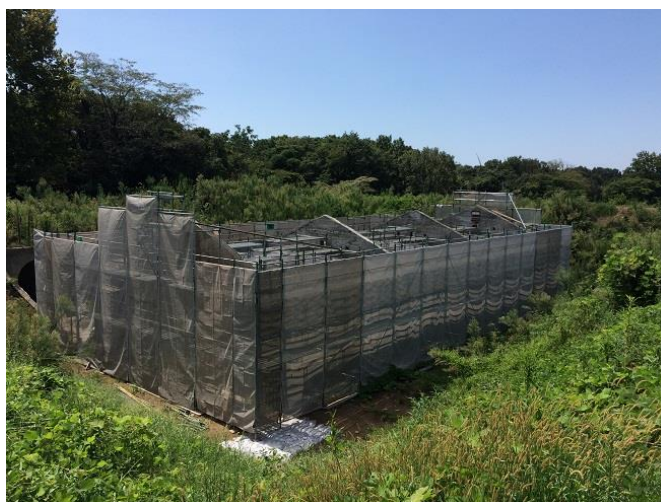
第三信管置場の保存整備工事の状況（H29.09）
