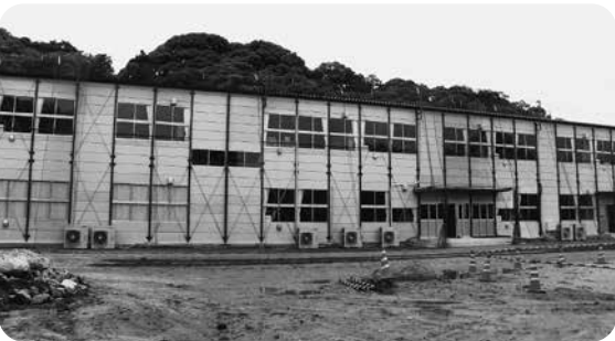
大規模改修時の仮設校舎
