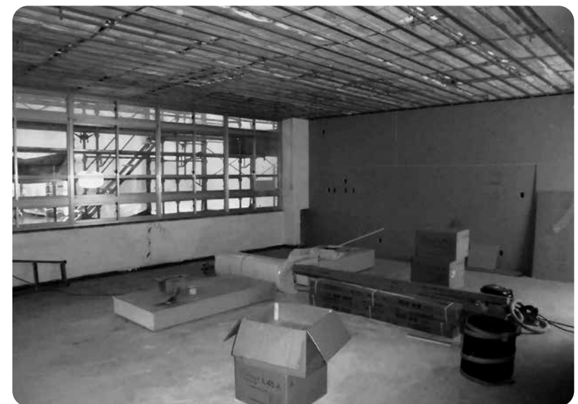
学校施設の改修
