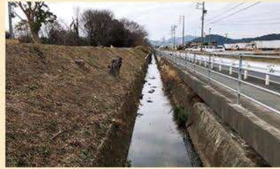
▲豊川海軍工廠平和公園北辺の土塁と排水路
