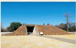
旧第一火薬庫 豊川市指定史跡
