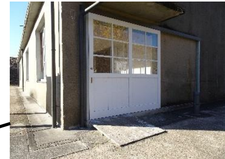
旧第三信管置場の出入口(東側) (スロープ設置) ※西側の出入口も同様
