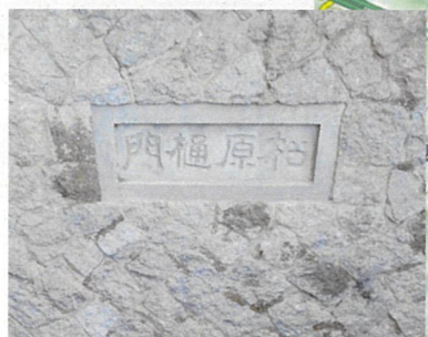
⑧松原樋門
