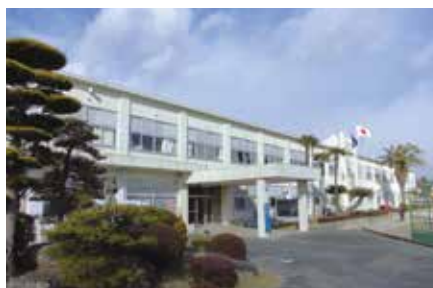
一宮東部小学校校舎改修事業
