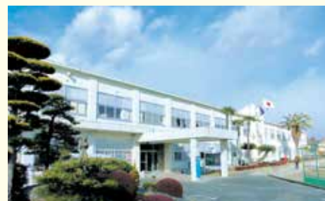
改修工事を行う一宮東部小学校
