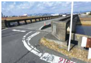
整備方針が架け替えとなった行明橋
