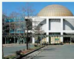
プラネタリウム機器が更新される ジオスペース館
