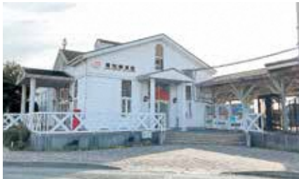
橋上化などが予定される愛知御津駅
