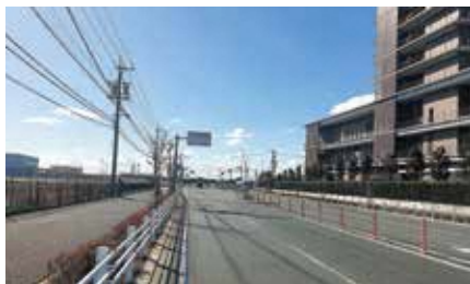
工場の解体が進んだ八幡地区
