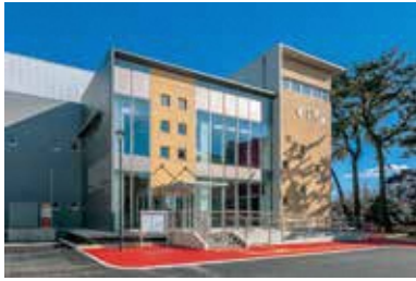
令和2年4月に開館した防災センター
