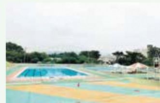
解体が予定される市民プール
