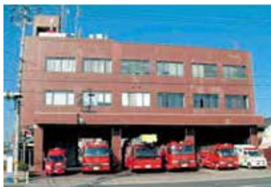
建設整備が検討される消防署本署
