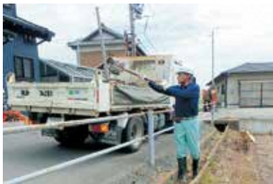
道路側溝の浚渫作業
