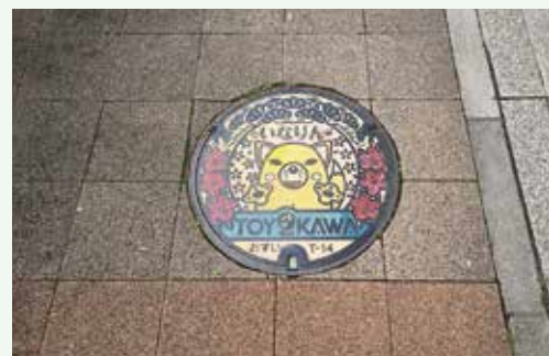
市内に設置されているマンホール
