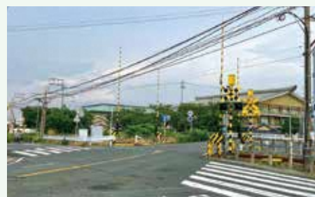
歩道設置工事前の諏訪町6号踏切道
