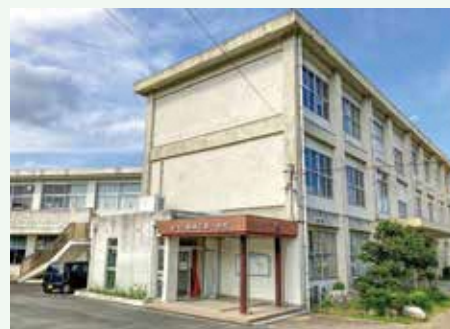
改修工事を行う御津北部小学校
