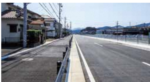
東三河環状線（大崎工区）
