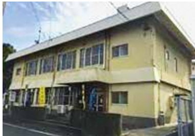
建て替えが予定される御油生涯学習センター
