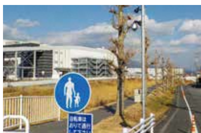
冠水が想定される箇所に監視カメラを設置
