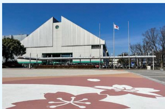
大規模改修工事を行っている総合体育館
