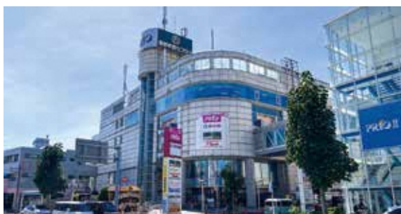
北東側から見たプリオビル
