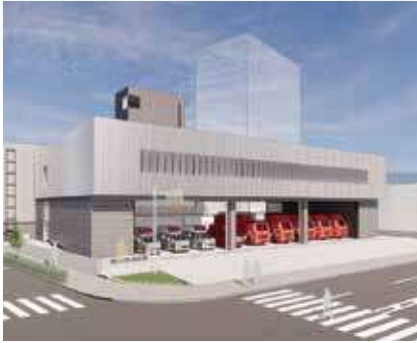
消防署本署の外観イメージ
