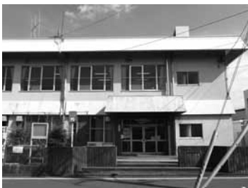
御油公民館(昭和48年建設)
