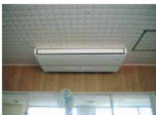
小中学校普通教室 空調設備設置事業
