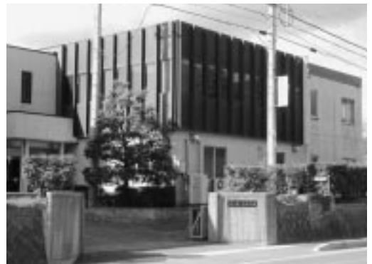
耐震壁の設置が必要と診断された一宮浄水場
