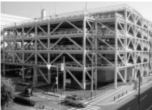
オープンから2年が経過した諏訪第2公共駐車場
