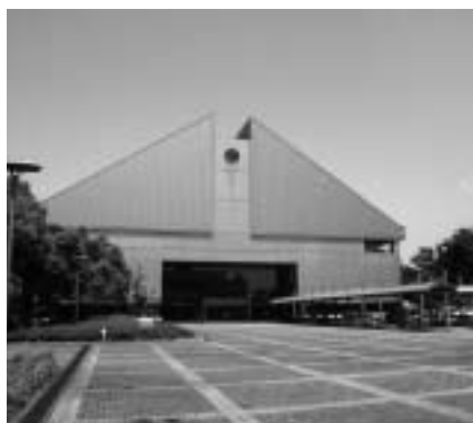
防火対象物である「総合体育館」
