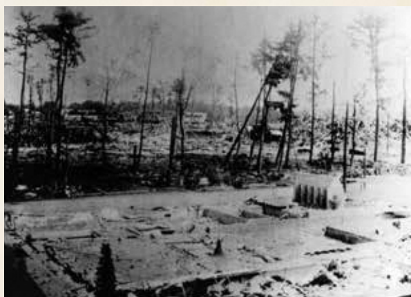
破壊された工場
