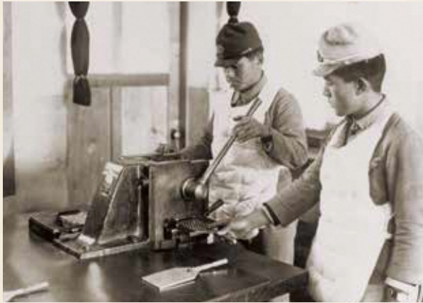
雷管圧填作業
