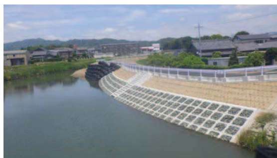
河川改修工事
