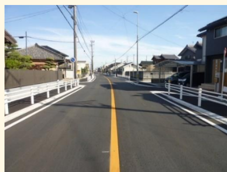
市道城跡市役所線（道路改良工事）
