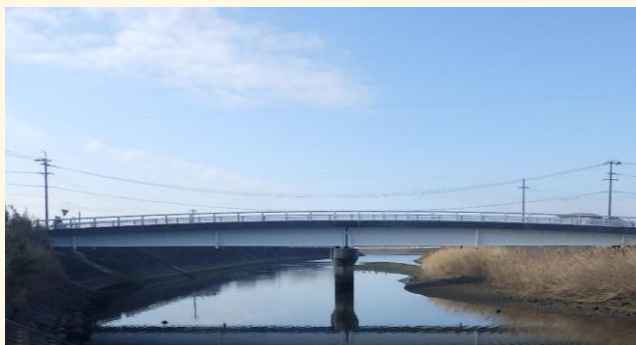
御所橋（橋梁補修工事）
