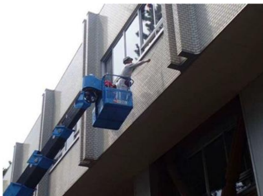
劣化調査状況（本庁舎）
