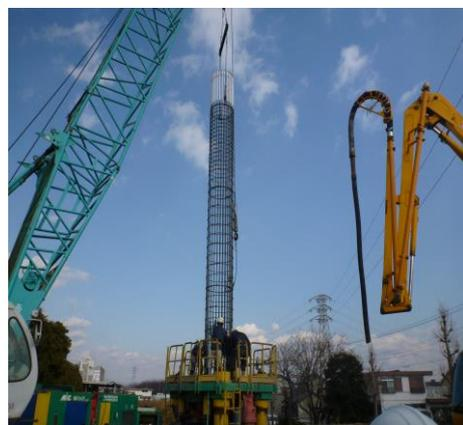
「橋梁下部工(基礎杭鉄筋かご挿入)」
