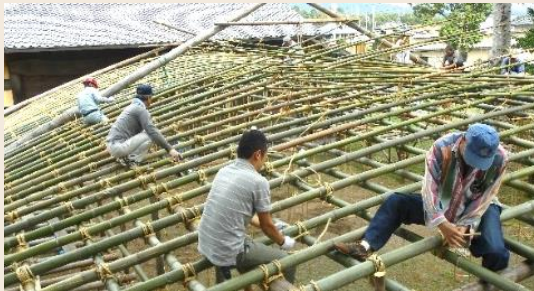
屋根竹組み作業の様子
