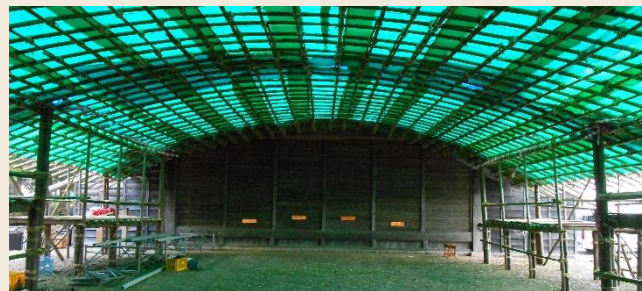
完成した小屋掛け
