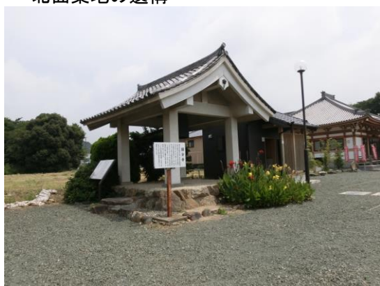
現国分寺の鐘楼（銅鐘：国指定重要文化財）
