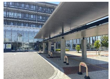
屋根付き通路(半田市)
