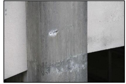
柱鉄筋露出
