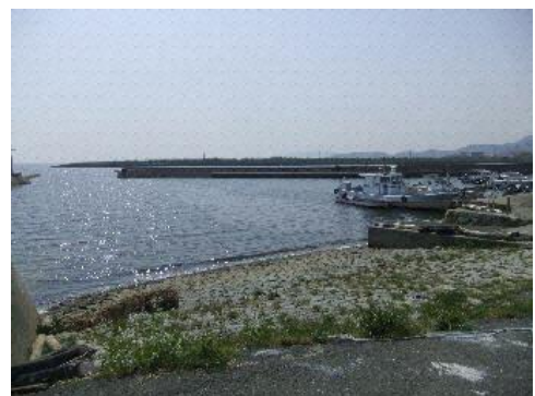
図 3-5 石敷きが残る現在の御馬湊
