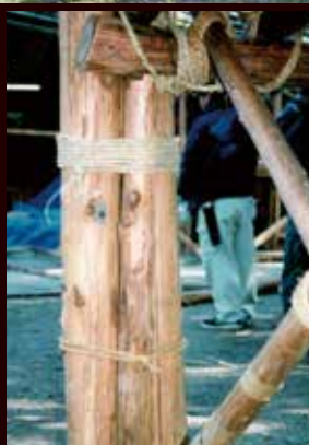
▲▶全て手作業で組み立てられる。支柱や竹組みは、釘を使わず1つ1つ縄で結び強度を高める。
