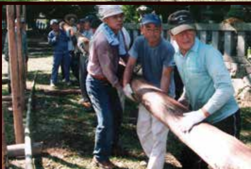
▲▶全て手作業で組み立てられる。支柱や竹組みは、釘を使わず1つ1つ縄で結び強度を高める。
