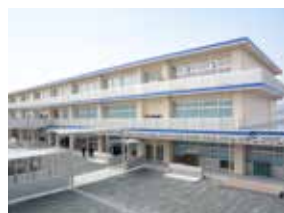
東部小学校校舎の改築
