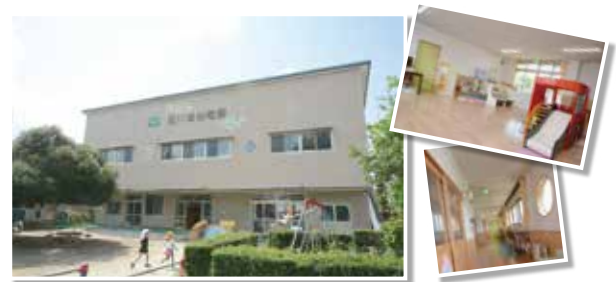
認定こども園への移行にあたり整備した豊川東幼稚園の新しい園舎
