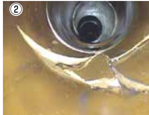
①平成26年8月の豪雨により冠水した道路 ②老朽化によりひび割れ、修繕が必要となった下水道管 ③下水道管内で発生した硫化水素により腐食したマンホール
