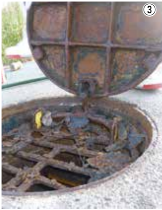
①平成26年8月の豪雨により冠水した道路 ②老朽化によりひび割れ、修繕が必要となった下水道管 ③下水道管内で発生した硫化水素により腐食したマンホール
